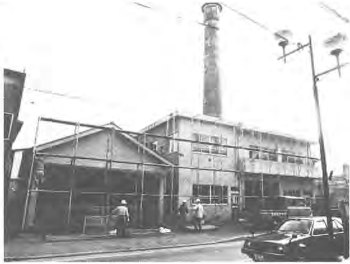
老朽化が進み、改築されることになった東部消防署
