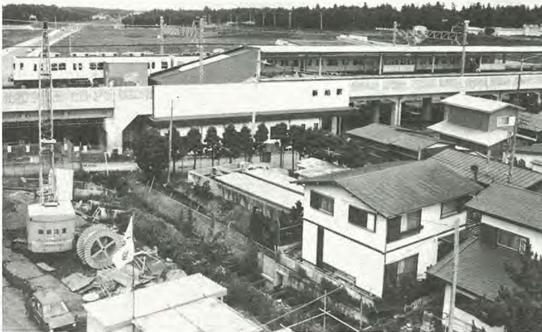
「新柏駅」の駅名表示も付けられ最後の仕上げに入った新駅(6月下旬撮影)
