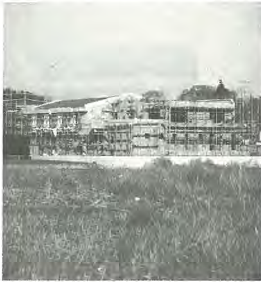
▲着々と工事が進む高田近隣センター (仮称)
