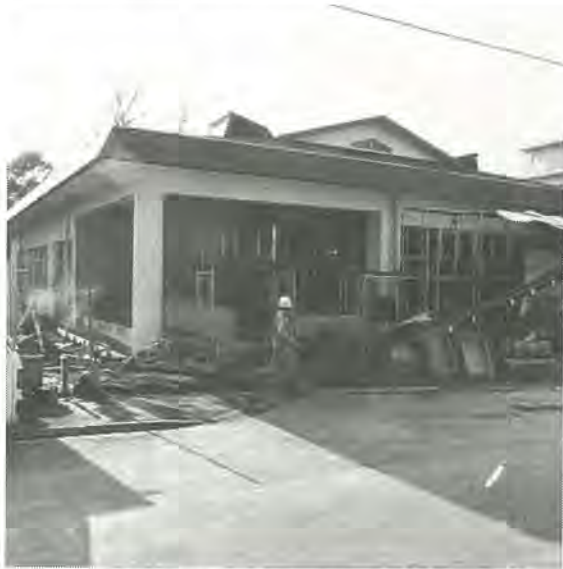
▲最後の仕上げに入った富里近隣センター (仮称)
