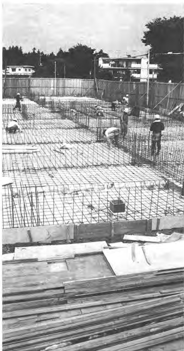
建設中の光ヶ丘近隣センター(仮称)
