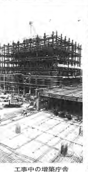
工事中の増築庁舎
