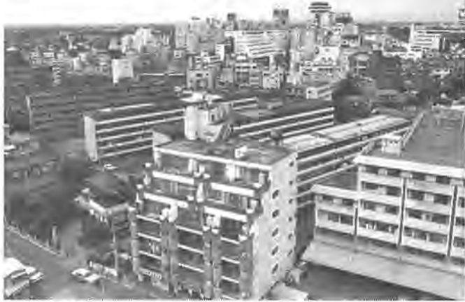
年々高層化する柏の街並み。これからは、街を形成するすべての建物が市独自の目でチェックできることに
