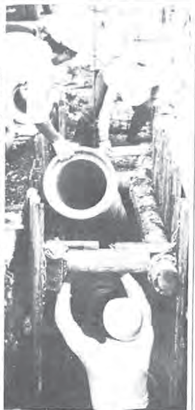
公共下水道工事
