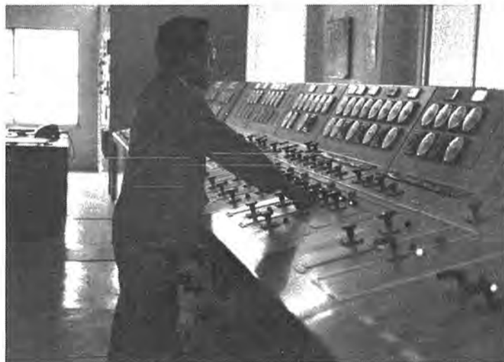
▲ <制御装置> 水の需要に応じて、取水・配水量・配水圧を調整する制御装置。日夜、正常な運転に目を光らせています。
