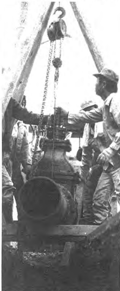
▲ <配水管埋設工事> 配水管は、水源地から各家庭に水を送るために埋設されます。柏市の配水管総延長は520キロメートル。新幹線の線路におきかえると、だいたい東京から京都までの距離になります。
