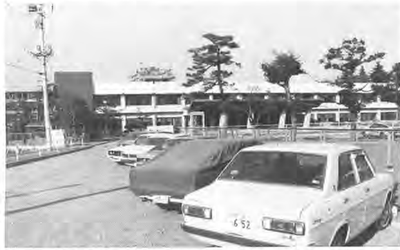
地域医療の核、国立柏病院としてのスタートも間近（正面の建物が外来棟、後方建設中の建物は入院病棟）
