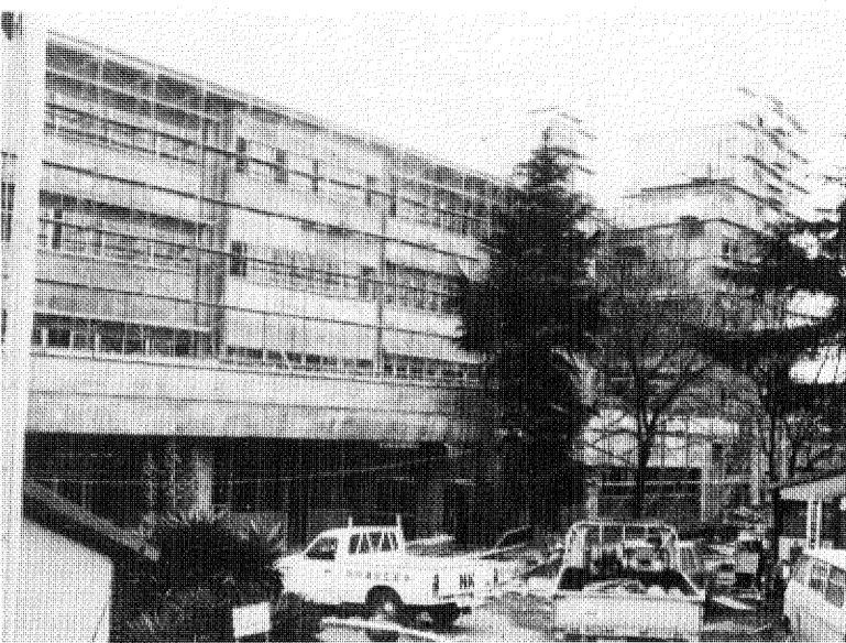
木造から鉄筋四階建の校舎に生まれ変わる柏三小の改築工事
