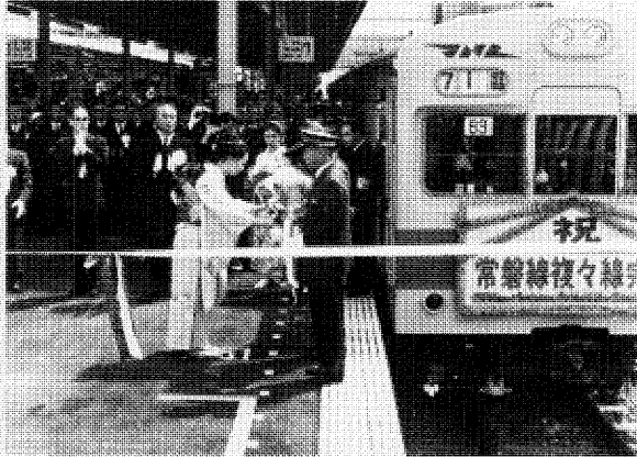
待望の常磐線復々線開通 (昭和46年)
