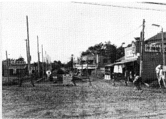
区画整理が進む柏駅西口付近 (昭和36年当時)
