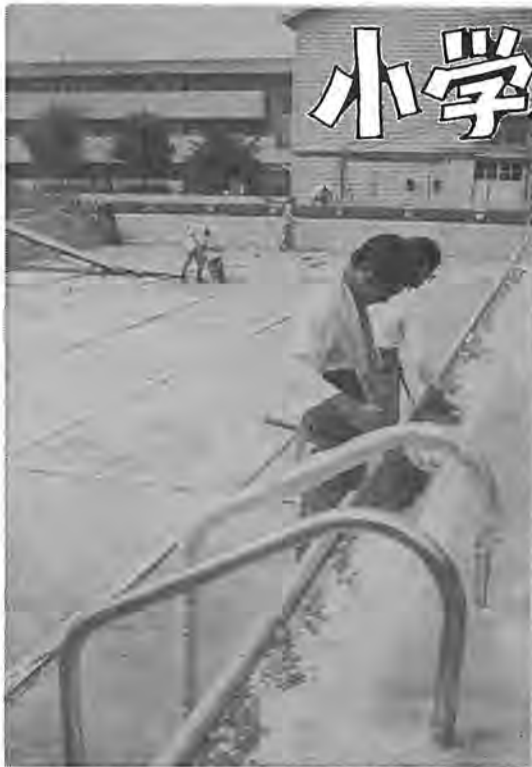
仕上げ工事を急ぐ柏一小プール
