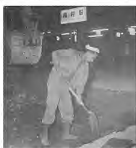
夜を徹して続けられる舗装工事
