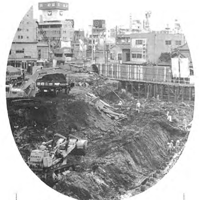
地下部分が掘り起こされて着々と工事が進むBビル建設現場(予想図で左側のビル)
