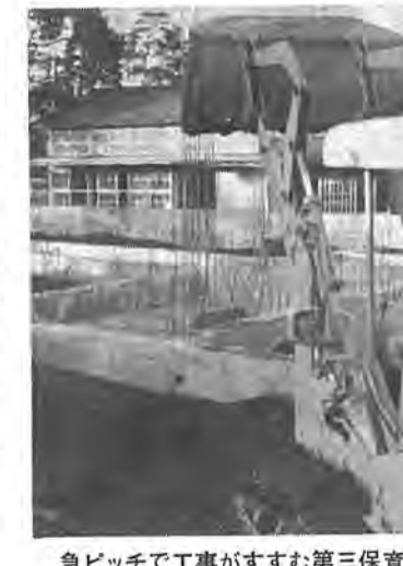
急ピッチで工事がすすむ第三保育園の改築
