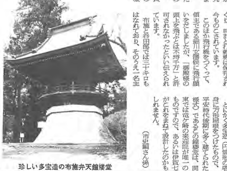
珍しい多宝造の布施弁天鐘楼堂
