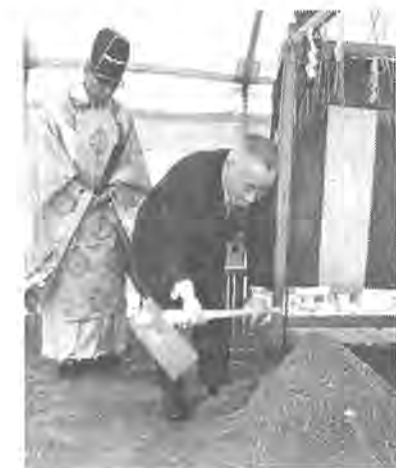
南柏駅舎改築で鉄入れをする山澤市長
