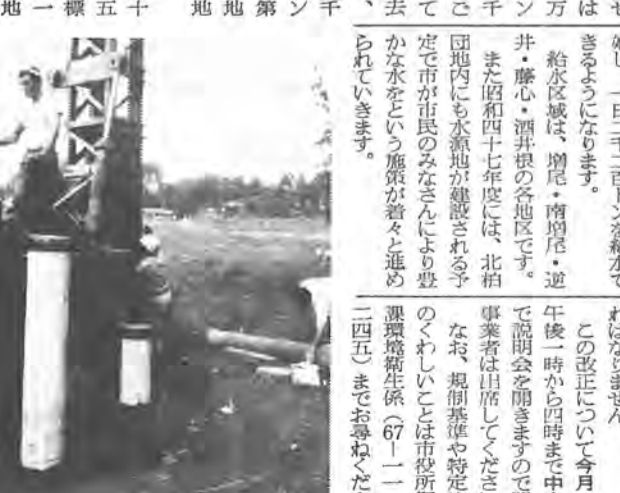
工事が始まった第四水源地
