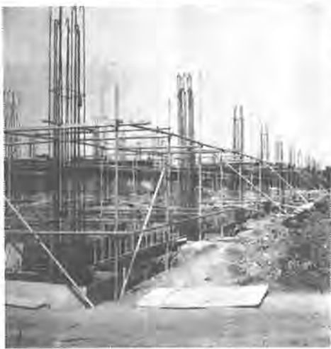
三小分離校の新設工事
