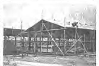
仮校舎の建築進む柏高校
