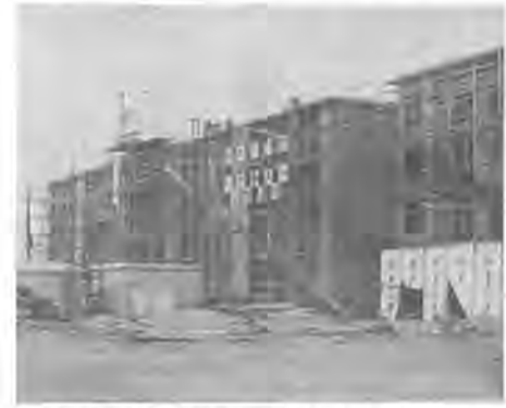
入居をひかえ急ピッチで進む市営住宅建築
