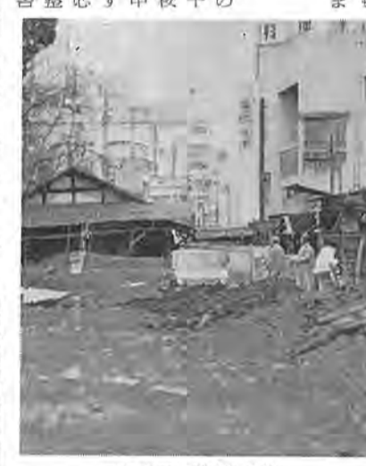
工事中の駅前縦貫道路
