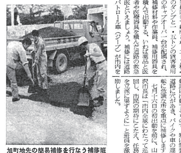
旭町地先の簡易補修を行なう補修班
