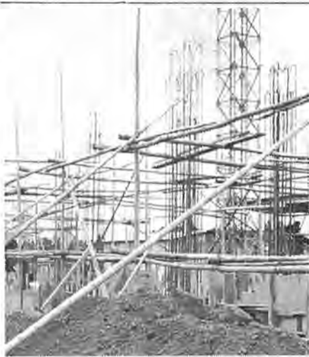
工事中の光ヶ丘中校舎
