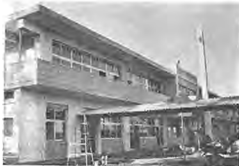
新しい規模で、新しい姿で進む学校建築
