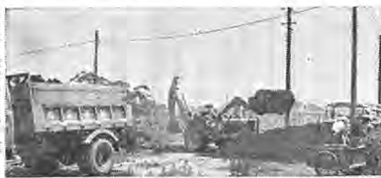
道路工事も力強く進む
