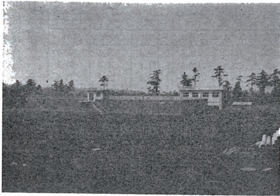
〔上水道才三水源地 全景〕
