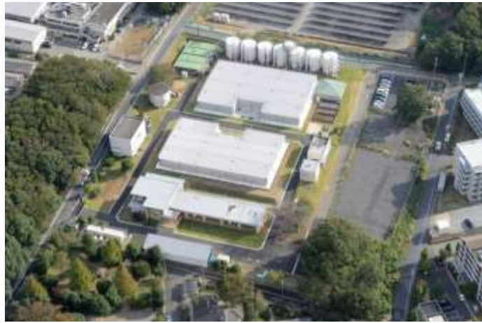
<耐震化された配水池(第三水源地)>
