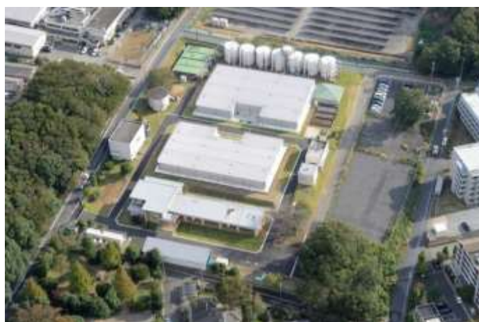
<耐震化された配水池(第三水源地)>
