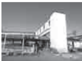
▲右に見えるのが構内エレベーター (3月19日撮影)
