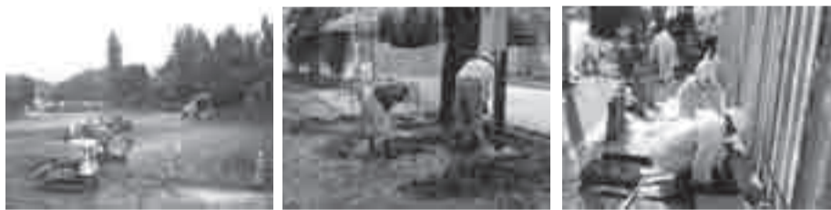
▲重機による削り取り ▲植え込み等は手作業で ▲汚泥・落ち葉の除去
