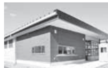
▲道の駅しょうなんの隣に建設中
