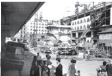
▲柏駅前工事とそごう柏店の建設の様子(昭和48年)
