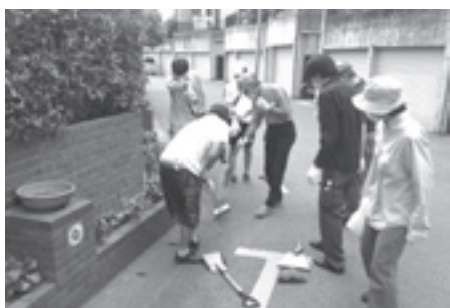
▲除染作業の様子
