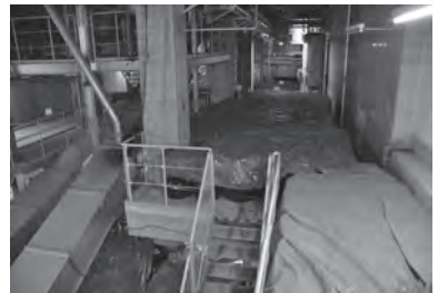
焼却施設内地下の空きスペース等で、ブルーシートで覆い保管しているドラム缶
