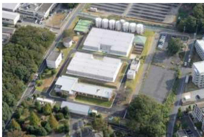
<耐震化された配水池(第三水源地)>
