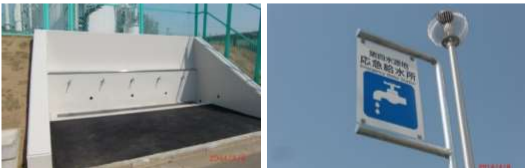
<応急給水設備>
