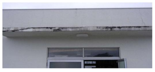
・2階屋上への出入口です。右上 部の壁にひびが入っており、老 朽化が進んでいます
