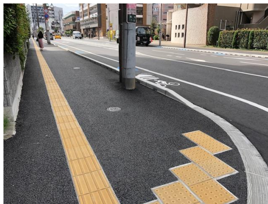
■ 南柏駅前線（施工後）
