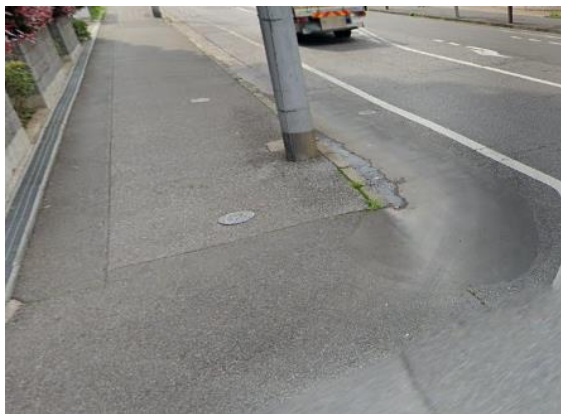
■ 南柏駅前線（施工前）
