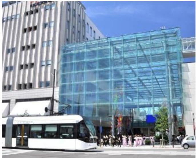
65m × 21mの広場空間を確保している。大型ビジョン、音響設備、可動式ステージや樹木を備え、イベント時には公共空地として貸出し可能である。再開発ビルの柱から屋根を吊り下げる構造により開放的視界を確保し、周辺ビルとの連絡通路を設置してアクセス利便性を高めている。年間平均稼働率は69.3%，休日は96.6%と高く、多様なイベントを通じて賑わいを創出している。
