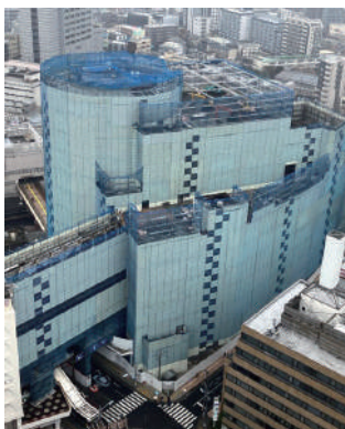
解体現場の全景
