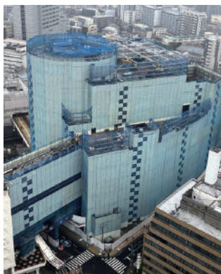
解体現場の全景
