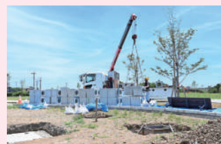
遊具の基礎を設置
