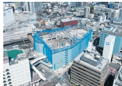
令和8年4月時点の解体状況
