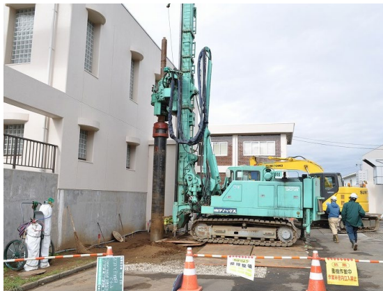
水源地の耐震化工事
