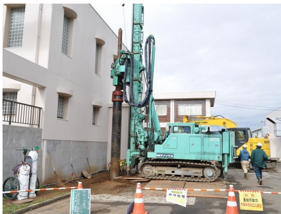
水源地の耐震化工事
