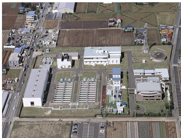
北千葉取水場（松戸市）北千葉広域水道企業団提供
