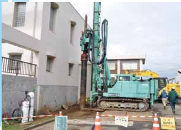
水源地の耐震化工事
