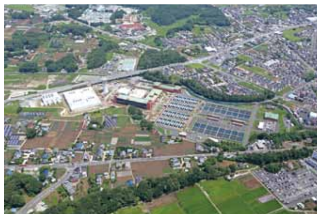
北千葉浄水場 (流山市) ※北千葉広域水道企業団提供
