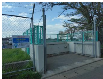
応急給水所（岩井水源地）
