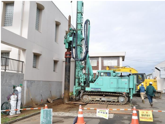
水源地の耐震化工事
