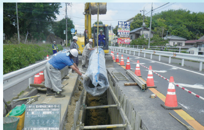
▲入れ替え工事の様子
