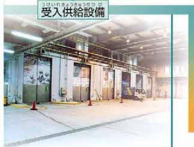
■プラットフォーム 搬入車のごみを投入する場所です。
