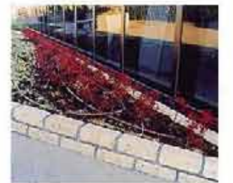
■雨水利用の散水用設備
