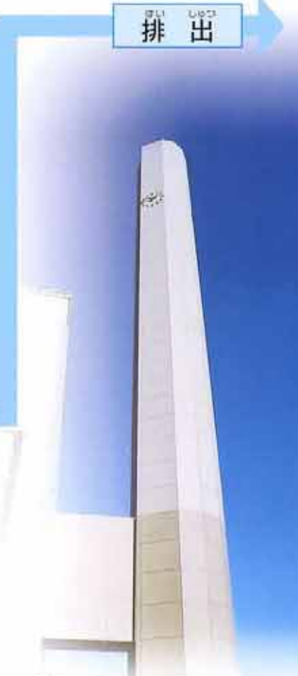
■煙突 鉄筋コンクリートの外筒と鋼製の内筒(高さ100m)で構成されており、排ガス処理設備を通った排ガスが大気へ排出されます。
