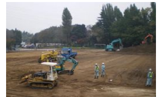
▲ 重機による削り取り
