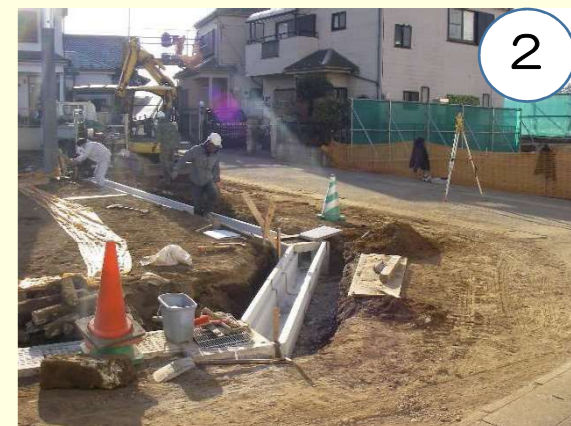
2 道路の拡幅に伴い、側溝を布設しています。
