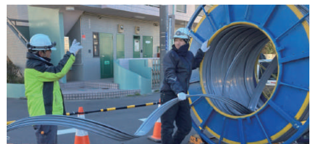
古くなった下水道管の内側に、細長い硬質塩化ビニル材をぐるぐると巻き付けて新しい管を造ります
