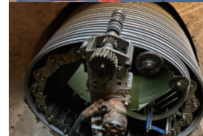
古くなった下水道管の内側に、細長い硬質塩化ビニル材をぐるぐると巻き付けて新しい管を造ります
