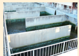
塩素がよく混ざるようくねくねした形に
