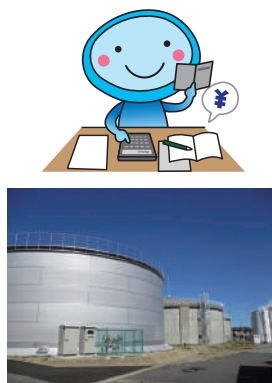
第五水源地の配水池
